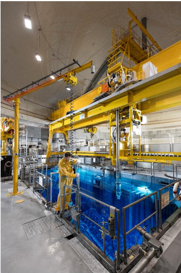
Zwischen 2025 und 2030 werden die Anlageteile zurückgebaut, die mit Radioaktivität in Kontakt gekommen sind (Foto: BKW)
