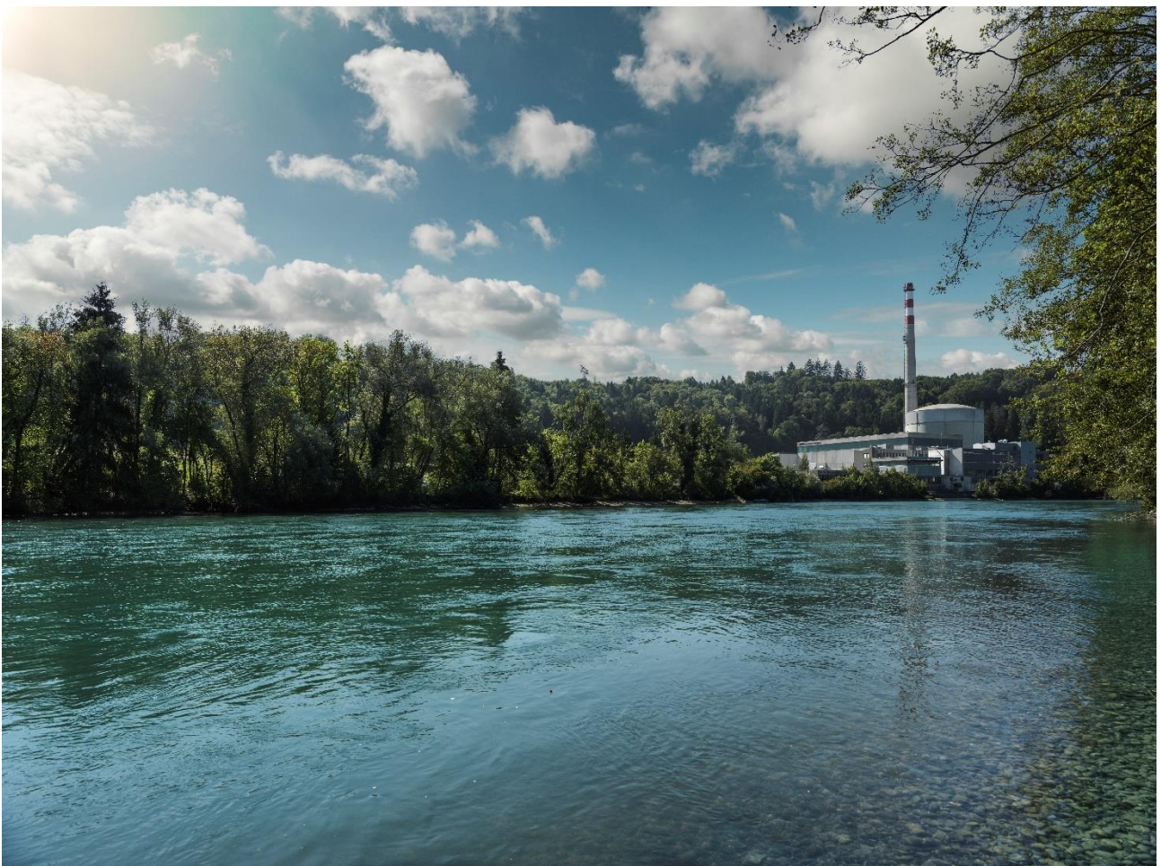
Ende 2030 wird das Areal frei von radioaktivem Material sein (Fotos: BKW)
