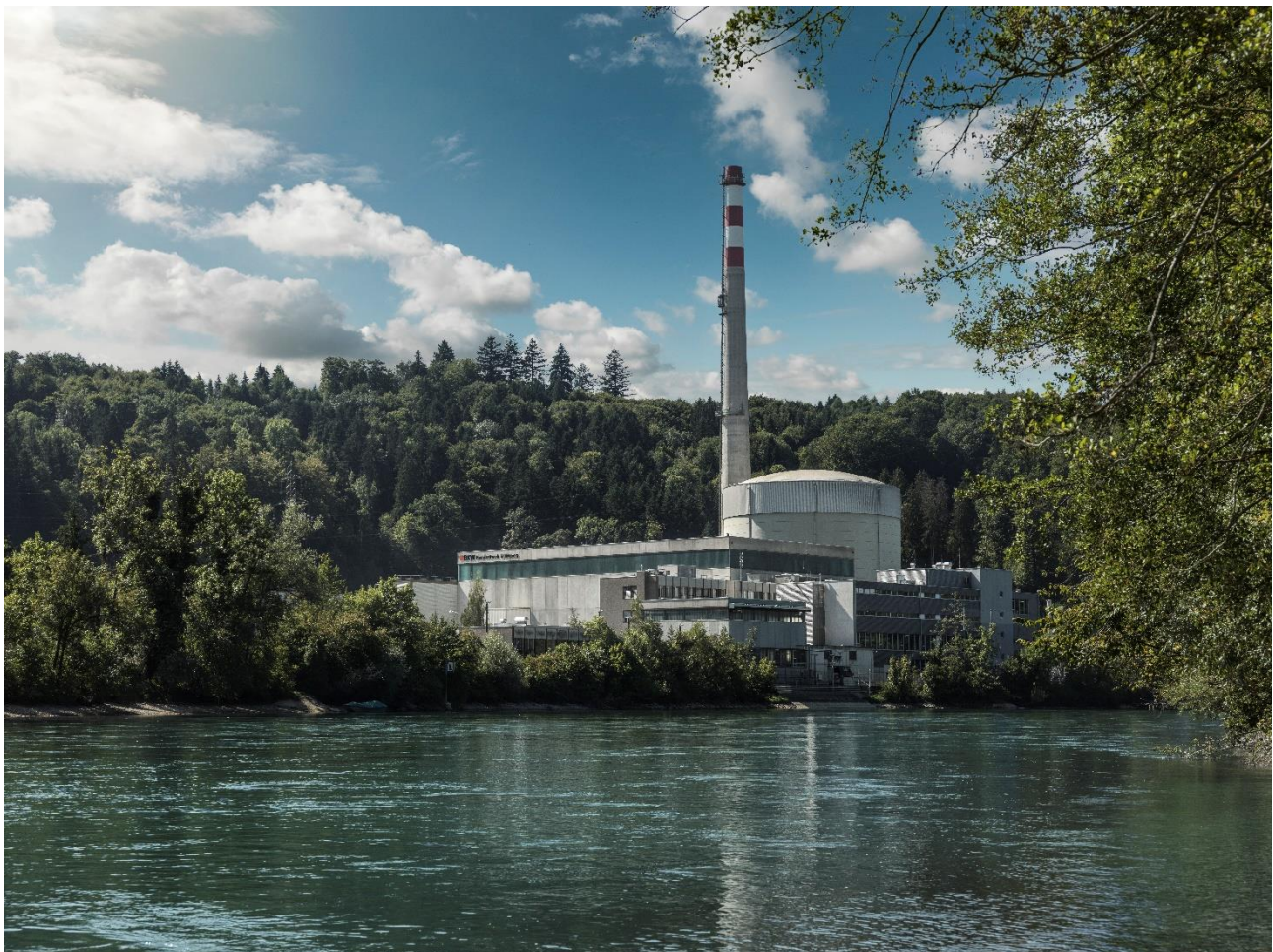
Das Kernkraftwerk Mühleberg ging am 20. Dezember 2019 endgültig vom Netz (Foto: BKW)
