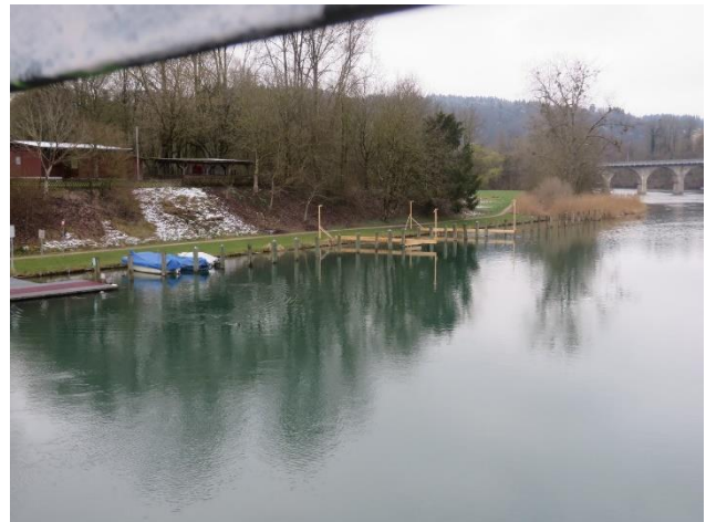
Bauprofil am 5.4.19, Blick vom Stägmattsteg zur Kappelenbrücke (Foto: E. Koene)
