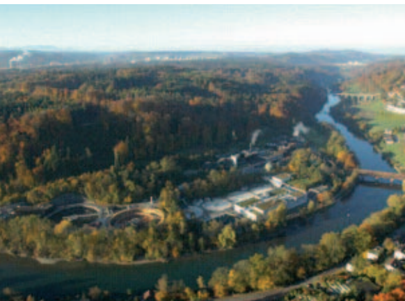
ARA Region Bern AG: Die drittgrösste Anlage der Schweiz
