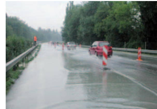
Überschwemmung Autobahn A6 Bern–Thun 2005
