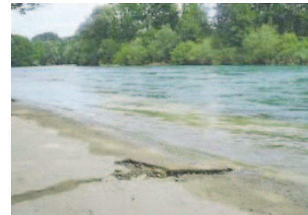
Aufgebrochener Damm nach Hochwasser
