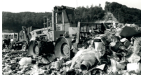
Einbau und Verdichtung von Siedlungsabfällen mithilfe schwerer Kompaktoren im Jahr 1989 (Foto: Deponie Teuftal AG).
