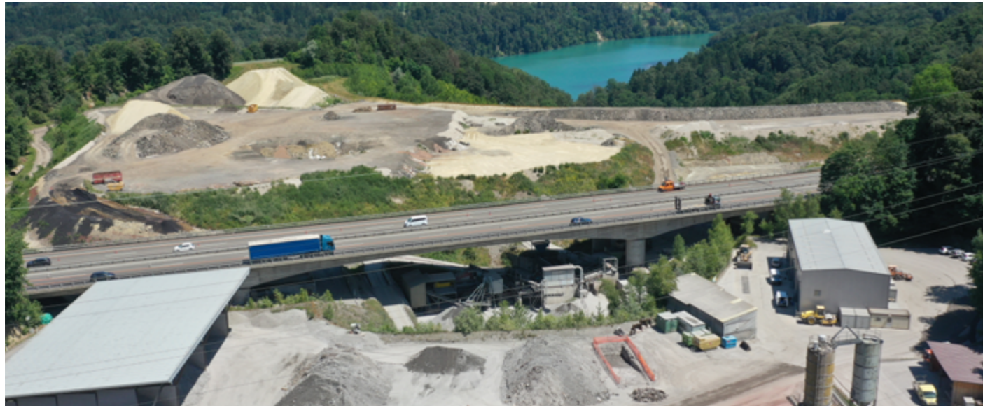
Infrastruktur- und Umschlagbereich der Deponie Teuftal, Blick nach Norden mit Wohlensee im Hintergrund (Foto: Deponie Teuftal AG).
