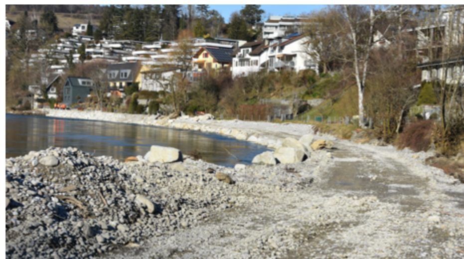
Temporäre Baupiste in der Aare.
