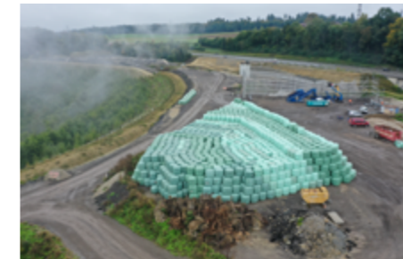
Ballenlager aus brennbaren Abfällen (Foto: Deponie Teuftal AG).
