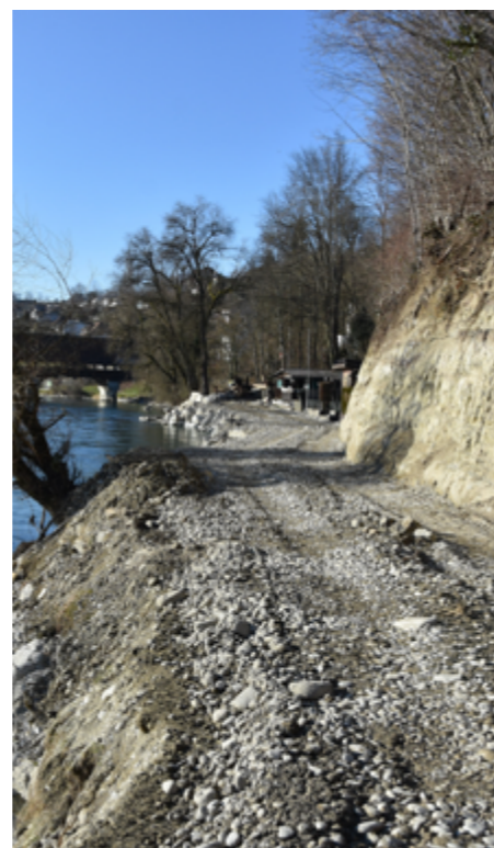
Felsabtrag für die Wegverbreiterung.
