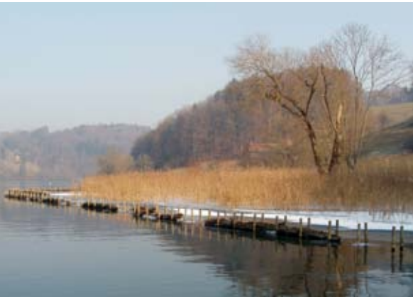
Reparaturarbeiten an der Lahnung
