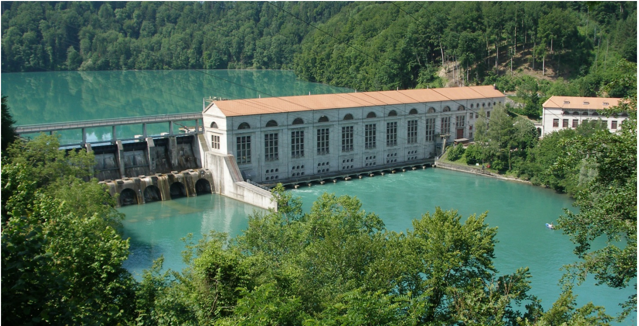
Wasserkraftwerk Mühleberg (Foto UW?)
