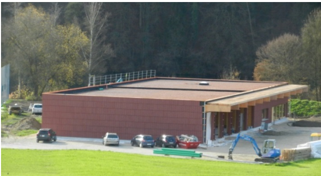
Sichtbare Baufortschritte in und ums neue Bootshaus. (Fotos ?)
