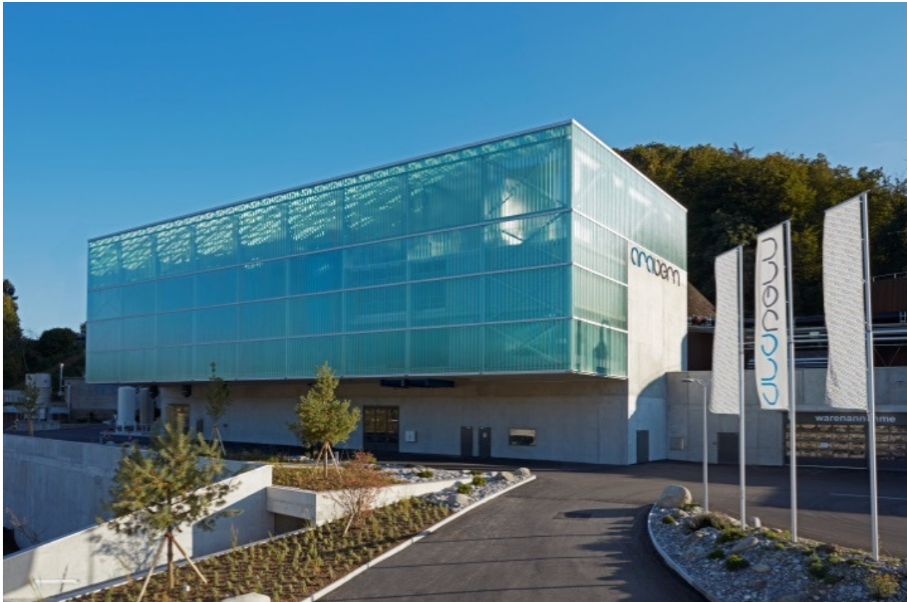
Fassade Schlammaufbereitung (Foto Isabell Schönholzer)
