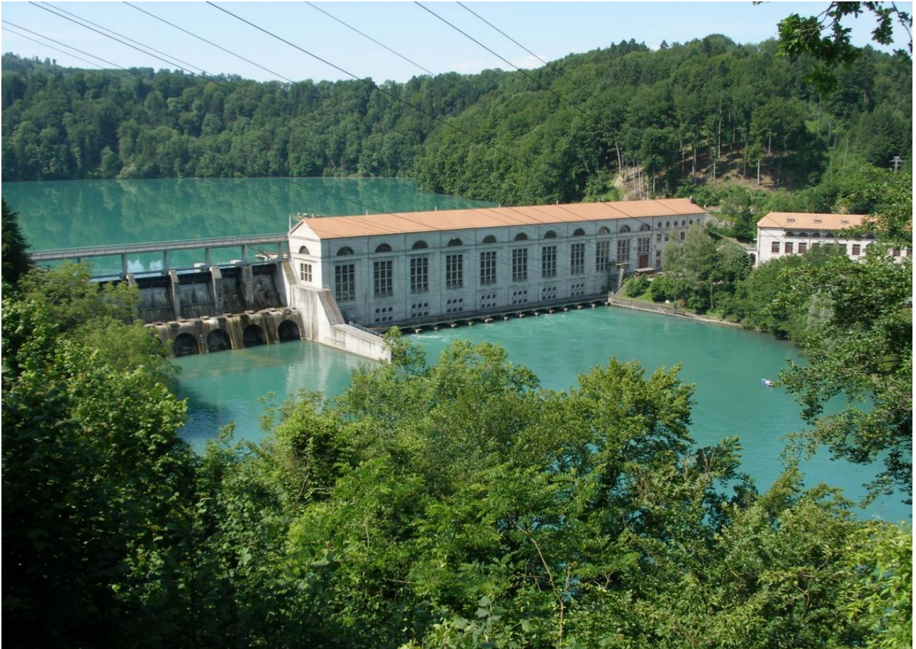
Wasserkraftwerk Mühleberg (Foto BKW)
