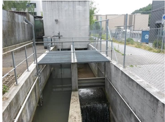
Blick gegen Fliessrichtung, Entlastung Stadtbach im Bereich Kleefeld. Links: Stadtbach. Rechts: Entlastungskanal Richtung Wohlensee, im Hintergrund das Rechengebäude (Foto: Frank Marti)
