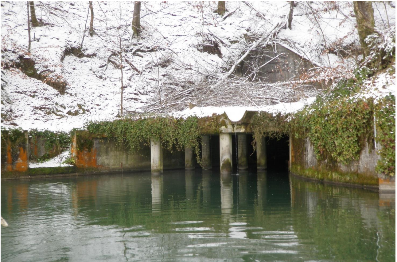
Oben: Blick in Fliessrichtung, Bestehender Entlastungskanal in den Wohlensee kurz vor der Mündung (Foto: Frank Marti) Unten: Einleitstelle des Entlastungskanals in den Wohlensee (Foto: Frank Marti)
