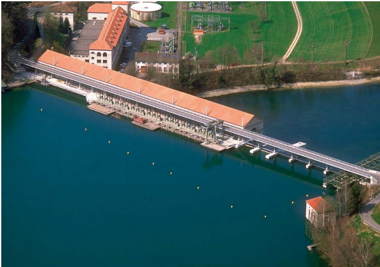
Abb. 9: Der Wehrübergang beim Wasserkraftwerk in Mühleberg.
