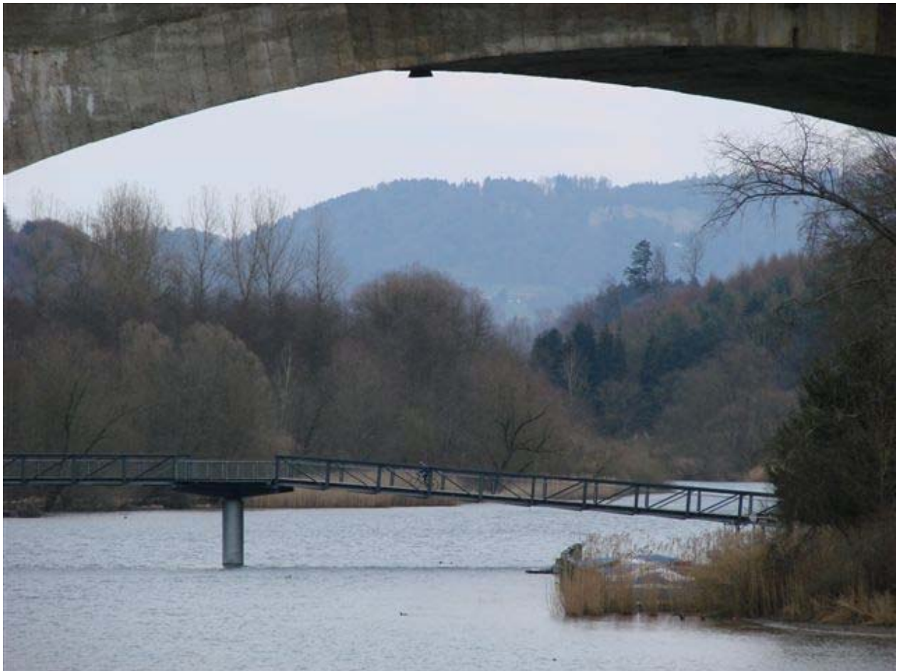
Abb. 6: Der neue Stägmattsteg aus Holz und Metall.
