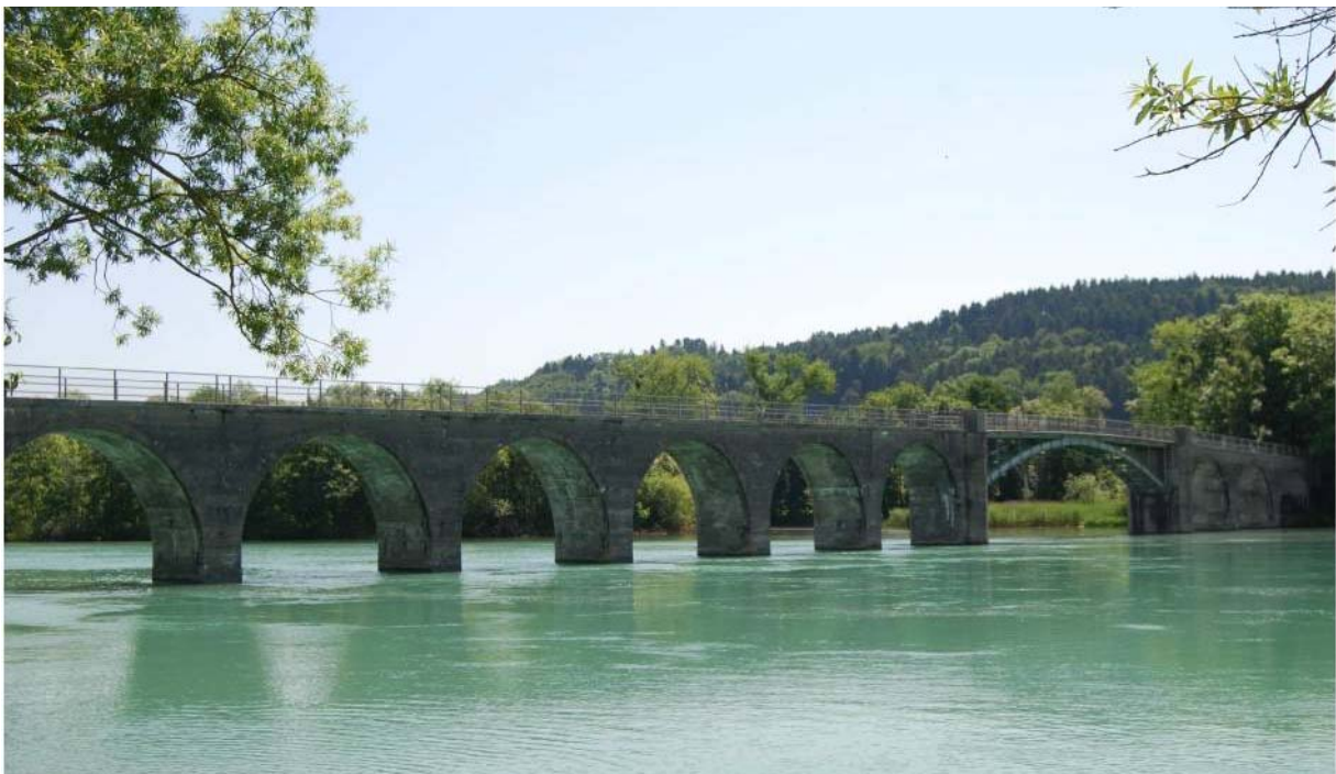
Abb. 8: Die neue Wohleibrücke ist eine 200 m lange Betonbrücke und besteht aus 16 Gewölbebogen. Der 30 m lange Hauptbogen hat eine Durchfahrtshöhe von 5.5 m über dem Wasserspiegel und liegt über dem alten Aarelauf
