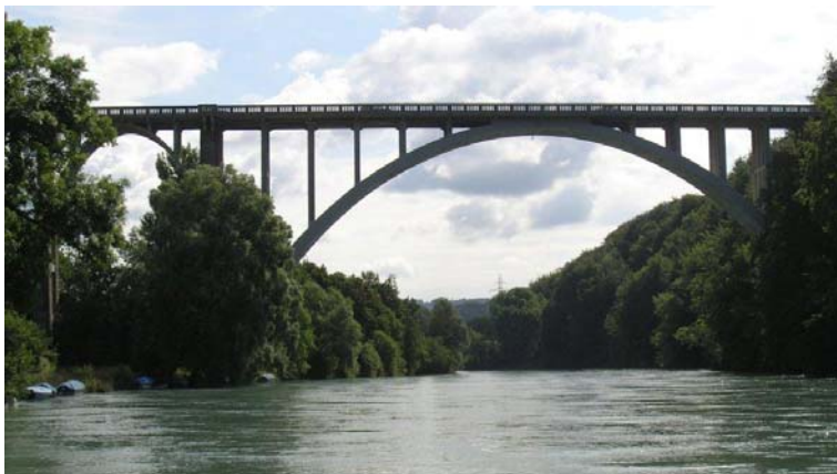
Abb. 1: Halenbrücke aus Beton.
