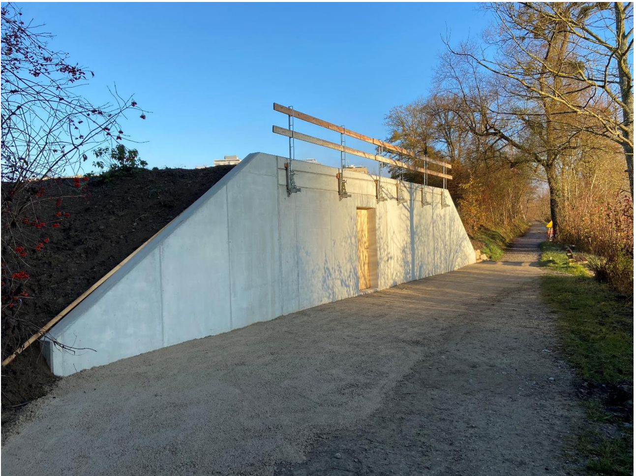
Das fertiggestellte Entnahmebauwerk auf der Parzelle des Schutzverbandes (Foto: R. Kohler)
