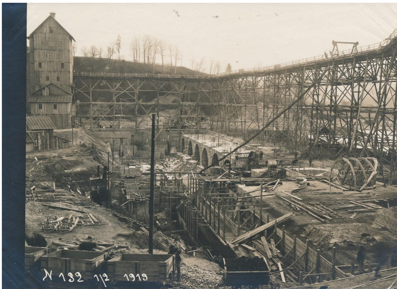
1919: Die Grossbaustelle in Mühleberg nimmt langsam Form an. Rund 1000 Arbeiter standen während dem Bau im Einsatz. (Foto: BKW)
