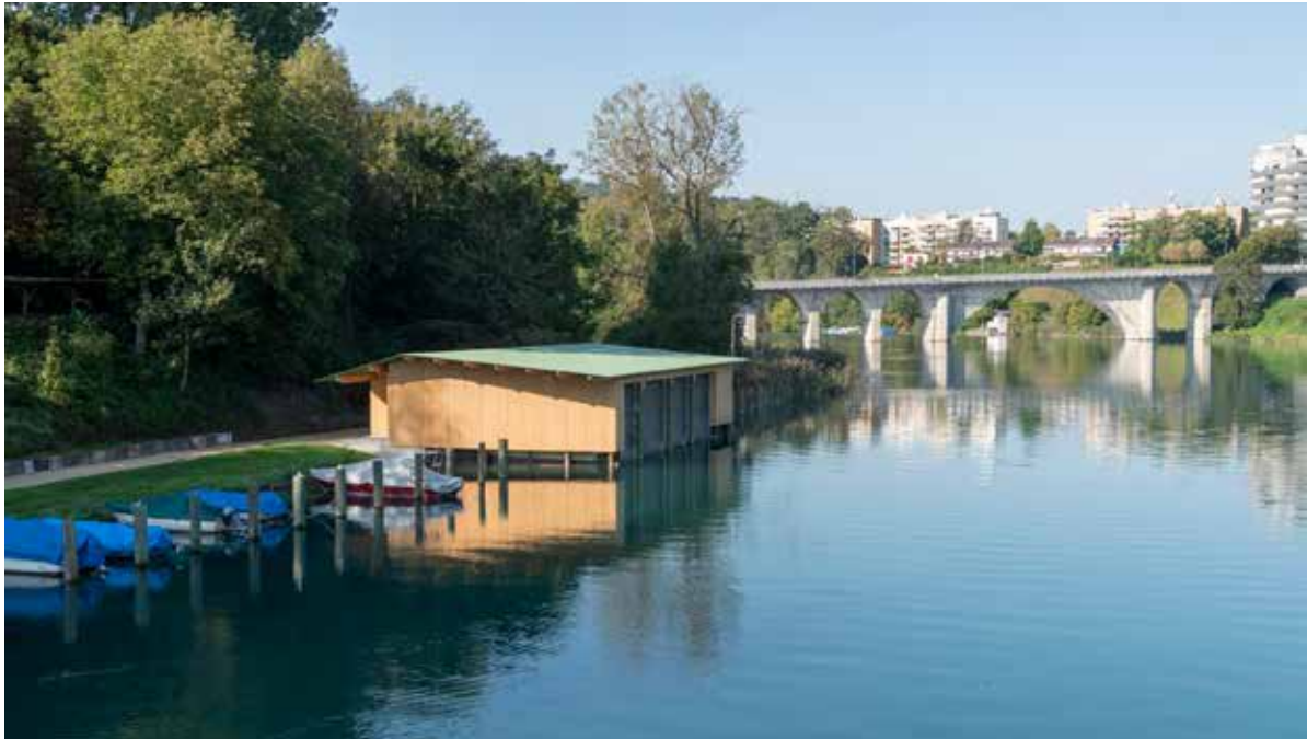
Das 2020 fertiggestellte Bootshaus der Seepolizei in der Berner Eymatt (Foto: Christine Blaser, Bildaufbau - Fotografie)
