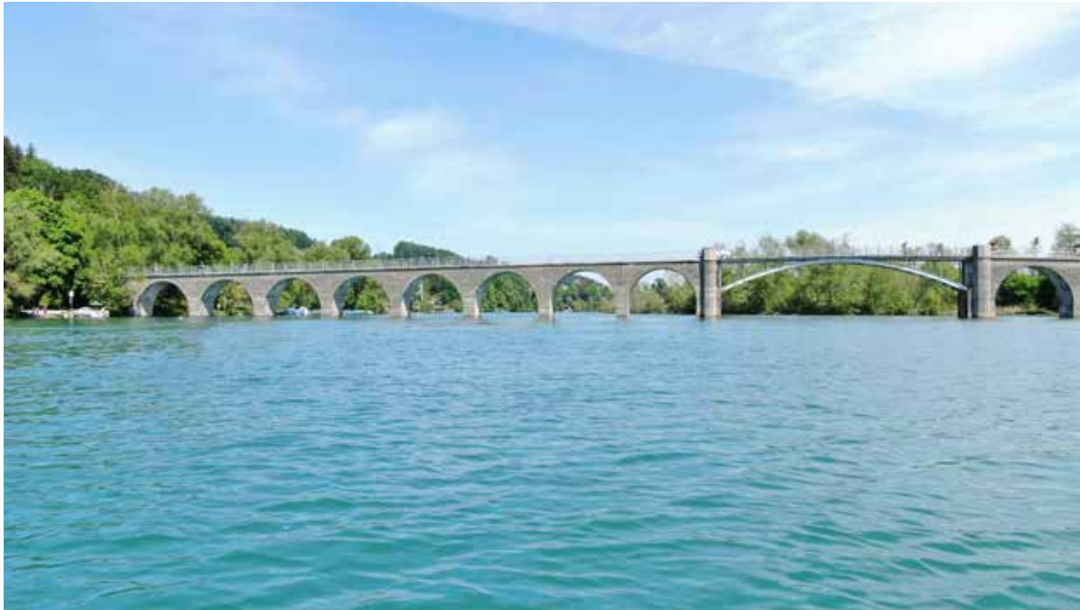
Die Wohlleibrücke von Westen aus (Foto: Markus Affentranger, Eyecopter)
