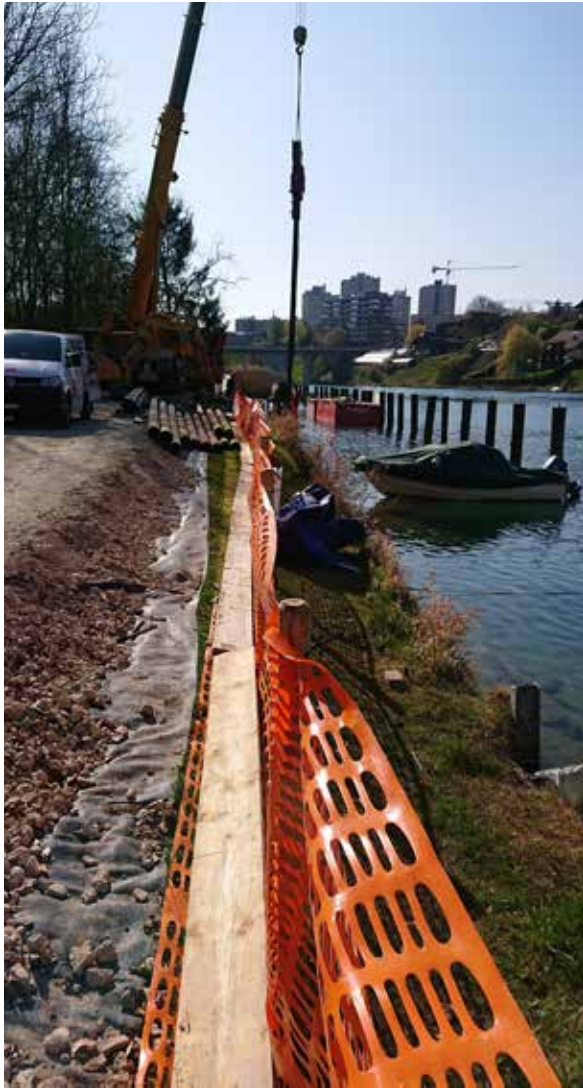
Absperrung zum Schutz des Schlupfgebiets während der Bauphase 2020 (Foto: Lukas Schär)
