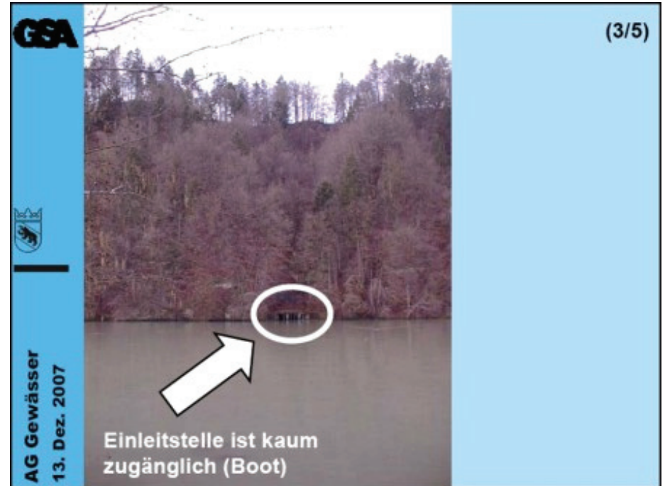
Einleitstelle des Schmutzwassers aus dem Gebiet Bümpliz Wangental
