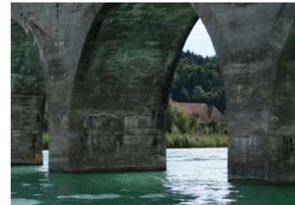
Der Zwergfledermaus genügt ein fingerdickes Einschlupfloch in einem Mauerhohlraum wie in der Wohleibrücke.
