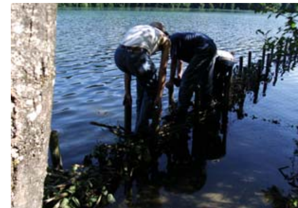
Einbauen der Haselstauden-Faschinen.
