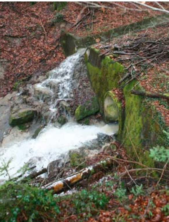
Ausfluss des eingedolten Illiswil-Bachs unterhalb der Deponie.
