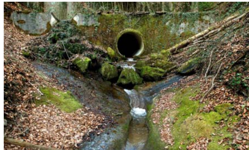
Sickerwasser aus der Deponie Illiswil.
