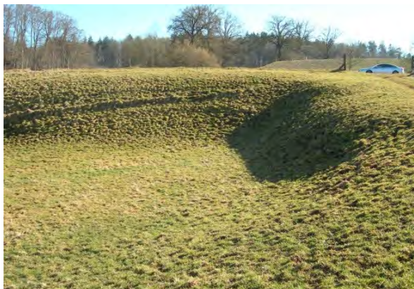
Heute sind nur noch die Dämme sichtbar, auf welcher die Strasse und die Bahnlinie von Mädersforst nach Riedbach führt
