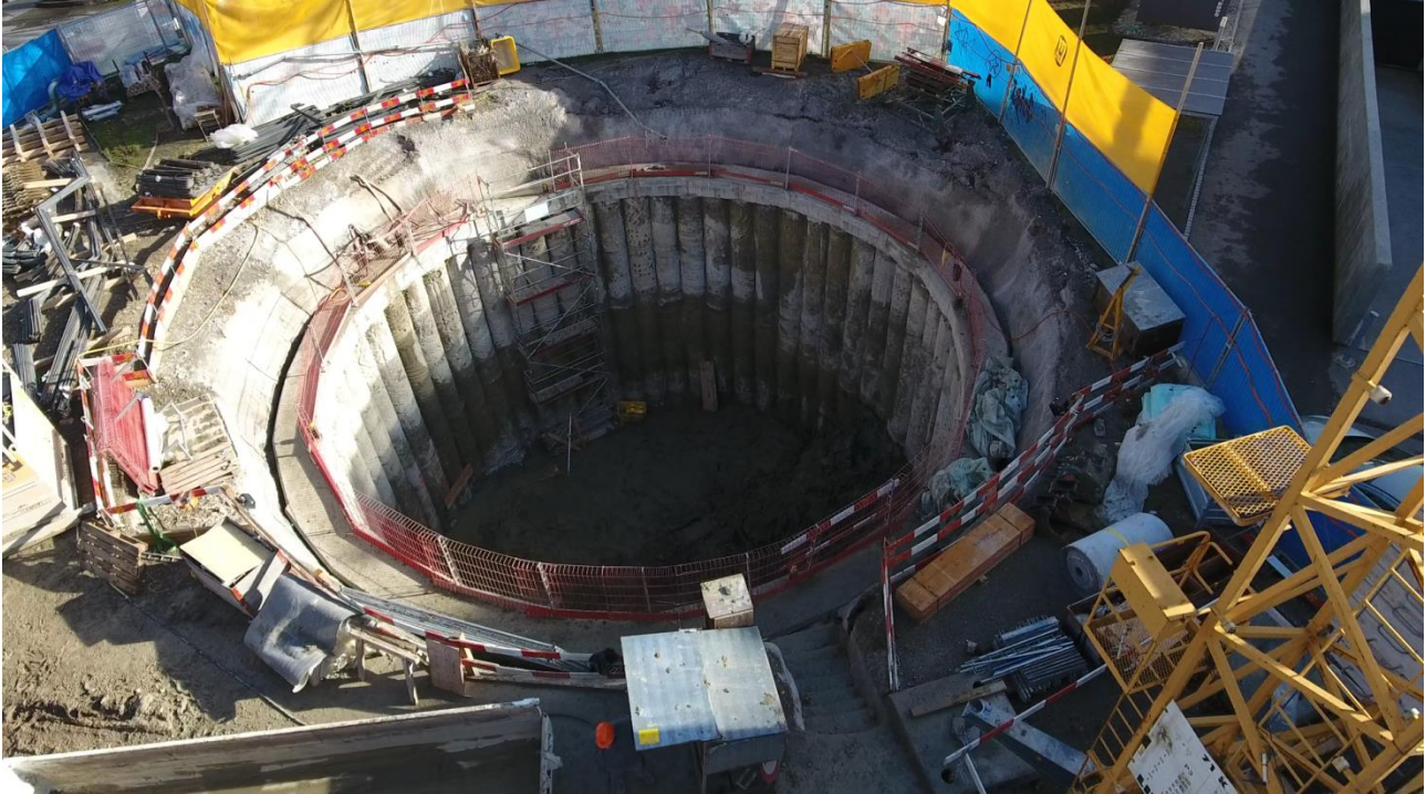
Stapelbecken (Foto: Bild: ara region bern ag)
