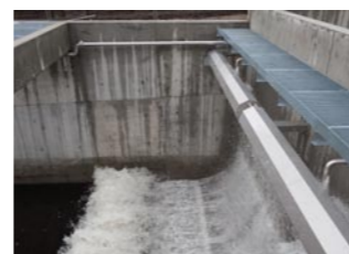
9 Spülkippen im Einsatz
