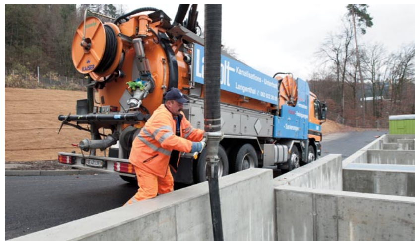
Der Bodenschlamm wird abgesogen
